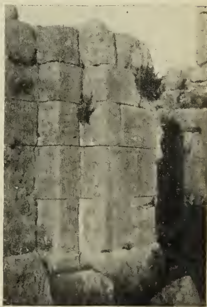
Pilastre N, vu du Nord.
